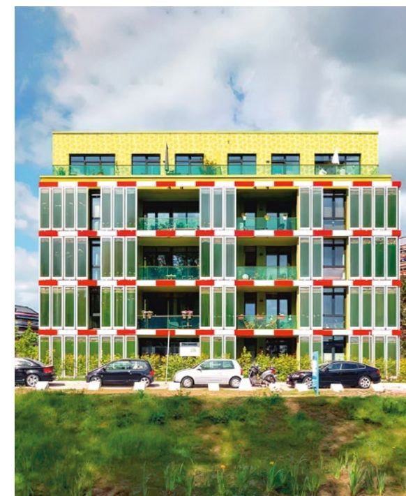
EL PROYECTO PILOTO SOLAR LEAF, BIG HOUSE, HAMBURGO (ALEMANIA) combina sistemas de sombreado con biorreactores de microalgas en la fachada, lo que permite producir tanto energía renovable como biomasa, al tiempo que contribuye a la captura de CO 2 atmosférico.
