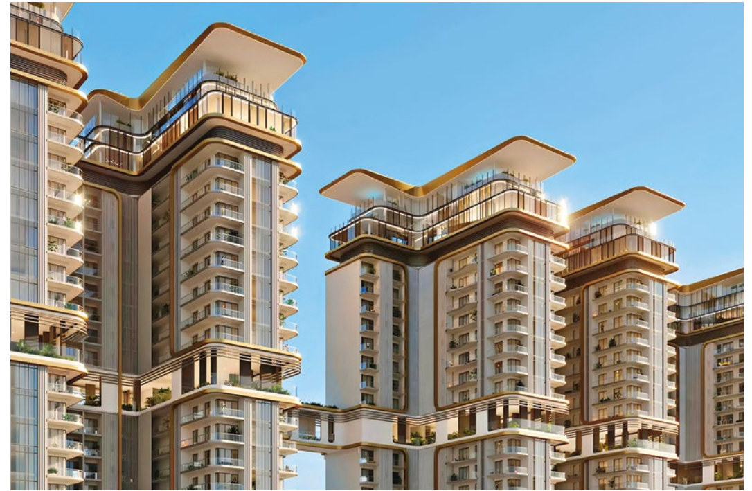
COMPLEJO AMARYLLIS PHASE 2 EN NUEVA DELHI (INDIA) ____ En este complejo residencial, el acristalamiento Cool-Lite® SKN 176 deja pasar el 70% de la luz natural y bloquea el 63% de la ganancia de calor solar. Esto permite a los ocupantes de este complejo, con certificación LEED Oro, disfrutar de la luz natural sin riesgo de un consumo energético excesivo.
